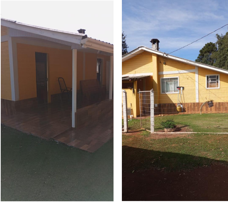
Foto 3 – Vista parcial da casa residencial em alvenaria medindo 100 m²
